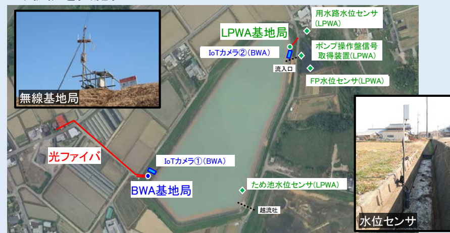
無線基地局を活用したため池、ポンプ場及び水路の遠隔監視／操作に関する実証状況
