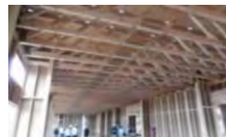
製材による大規模トラス
