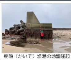
鹿磯(かいそ)漁港の地盤隆起
