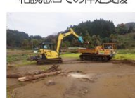
農地の堆積土砂・流木の撤去
