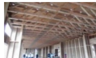
製材による大規模トラス
