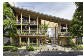
NISHIGAWA TERRACE(岡山市) [令和7年度木材利用推進コンクール内閣総理大臣賞]
