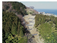
復旧した山腹崩壊現場
