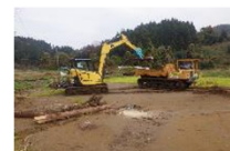
農地の堆積土砂・流木の撤去
