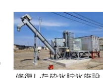
修復した砕氷貯氷施設
