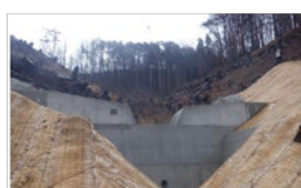
山火事跡地における治山ダムの設置 (左: 設置前 右: 設置後)
