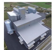
再編集約化後の新設施設
