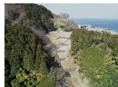
復旧した山腹崩壊現場
