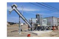
修復した砕氷貯氷施設
