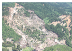
山腹崩壊 (令和6年1月の地震)
