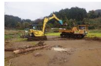
農地の堆積土砂・流木の撤去
