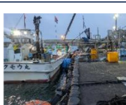
仮復旧工事により水揚げが可能となった鹿礁漁港
