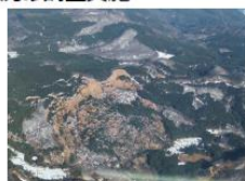
大規模な山腹崩壊
