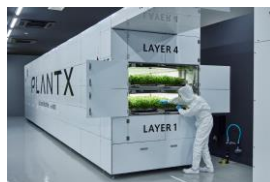
密閉型構造の植物工場
