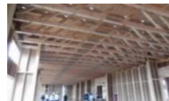
製材による大規模トラス
