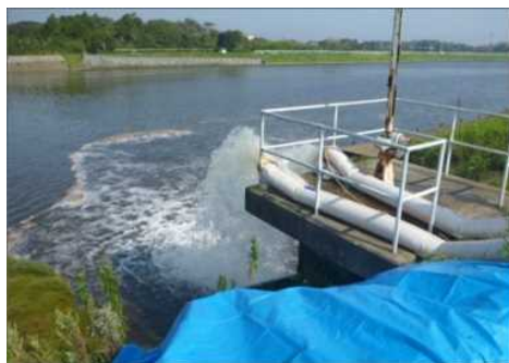
排水作業状況（東部排水機場）
