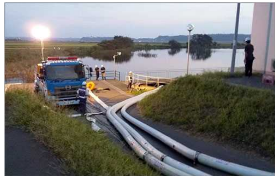
排水作業状況（宗吾北機場）
