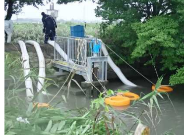
ポンプ設置状況
