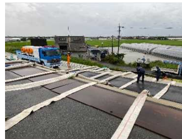
60m 3 /minポンプ車排水作業
