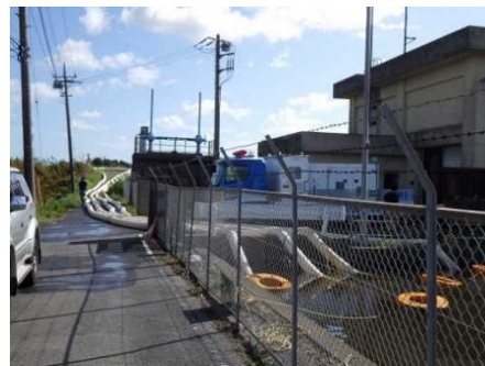
排水作業状況（屋形排水機場）
