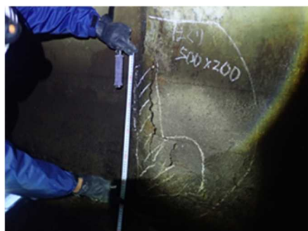
写真-2 機能診断調査（トンネル）の実施状況 (平成30年度：群馬用水)
