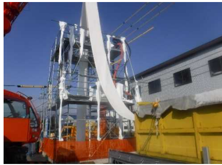
写真-11 機能保全対策（管更生）の実施状況 （令和3年度：三重用水）
