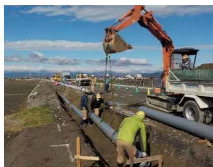
写真-9 機能保全対策（敷設替え）の実施状況 （令和2年度：木曽川用水）
