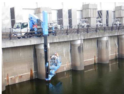
写真-4 機能診断調査（機場）の実施状況 （令和3年度：群馬用水）
