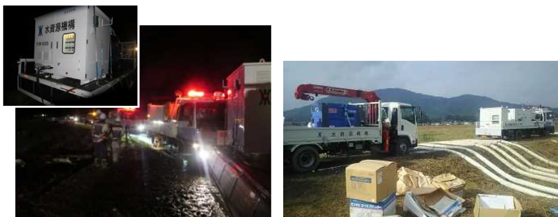
ポンプパッケージ 10m 3 /min排水作業（佐賀県大町町）
