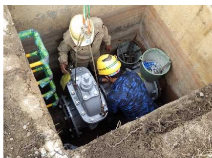
写真-10 機能保全対策（制水弁据付）の実施状況 （令和3年度：木曽川用水）
