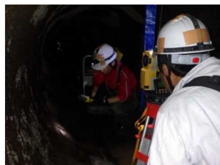
写真-3 機能診断調査（管路）の実施状況 (令和2年度：福岡導水)
