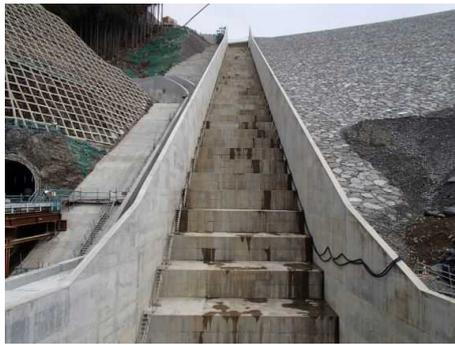
写真-7 採用した階段式の洪水吐き
