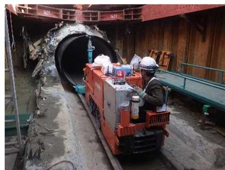
写真-9 水路改築工事実施状況 (左：鋼管挿入、右：ダクタイル鋳鉄管挿入)
