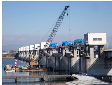
写真-13 利根大堰開閉装置更新実施状況 (左・右：開閉器更新状況)
