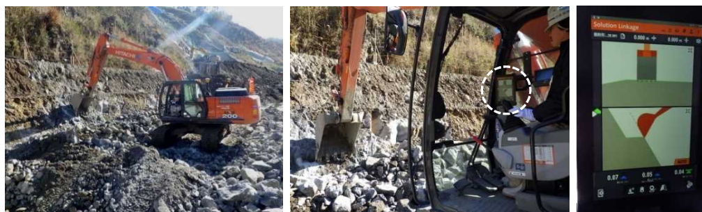
(a) 掘削作業状況
