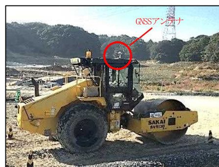
写真-2 GNSSを用いた締固め管理
