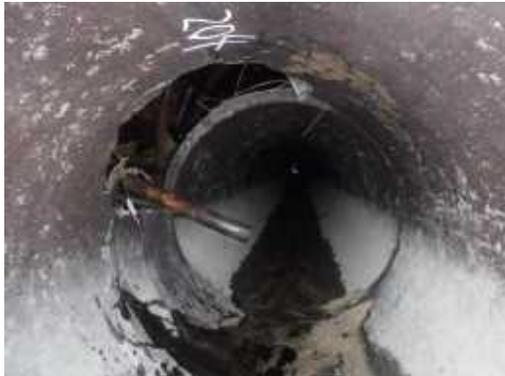
写真-4 PC管損傷状況
