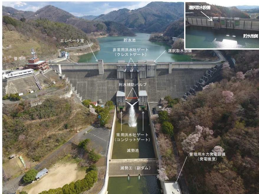
図-1 ダムの基本的な設備例（一庫ダム：重力式コンクリートダム）
