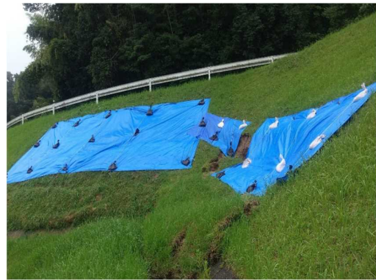
（法面応急復旧状況）
