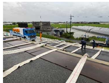
60m 3 /minポンプ車排水作業
