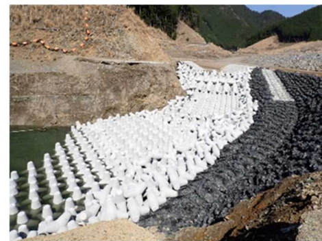
(河床水路の復旧状況)
