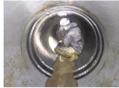
継手補強材設置状況
