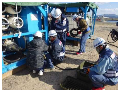
可搬式浄水装置の組立状況
