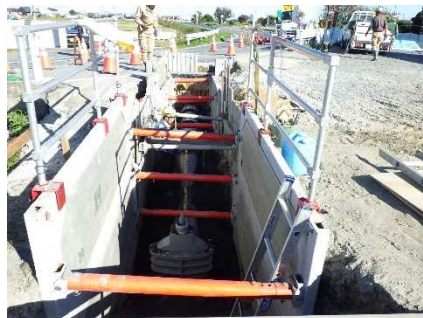
写真－3 機能保全対策の実施状況（木曽川用水（付帯施設更新））
