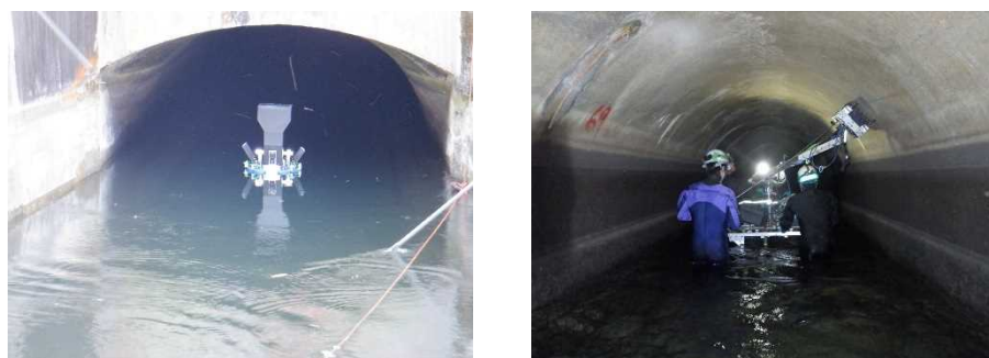
(左：通水点検装置車による背面画像撮影、右：通水台車による背面空洞調査)
