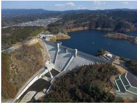
(試験湛水中 (令和5年3月))
