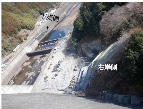
(準備工事：建設発生土受入地擁壁他工事)
