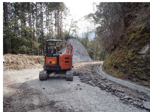
(準備工事：工事用道路拡幅工事)
