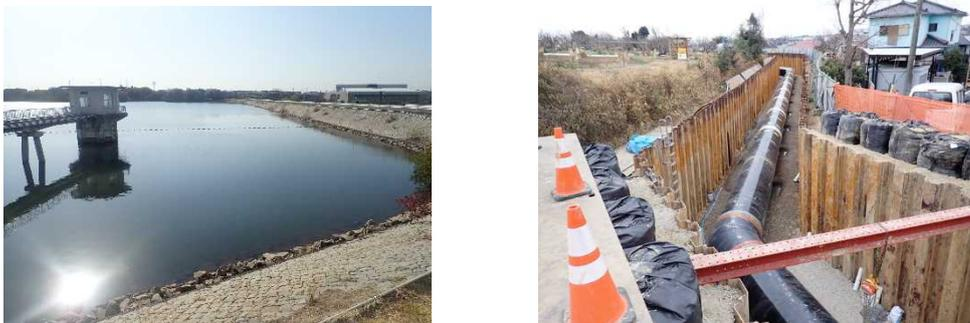
写真-4 改築工事実施状況（左：三好池堤体補強[完成]、右：三好支線水路）
