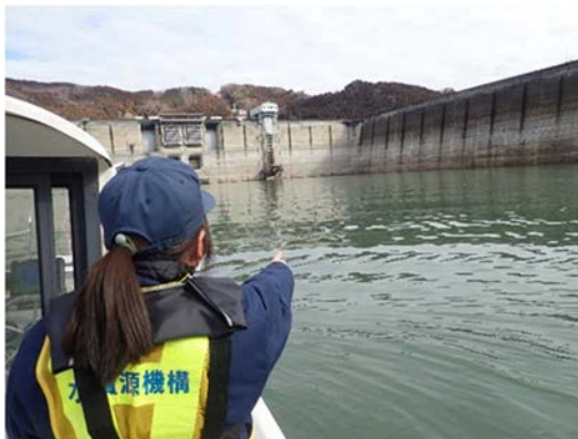
写真-1 船舶による巡視 (下久保ダム)
