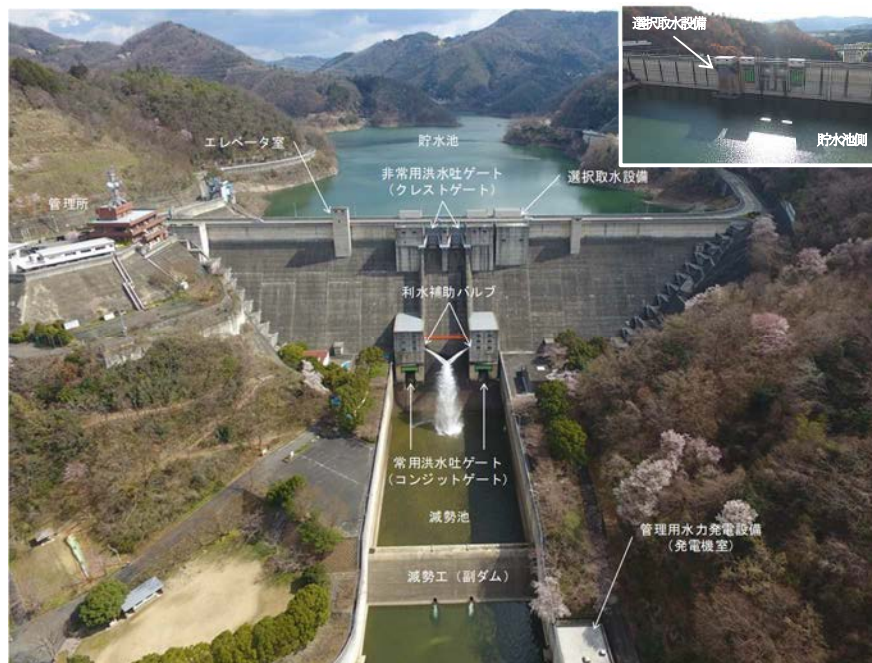
図－１ ダムの基本的な設備例（一庫ダム：重力式コンクリートダム）
