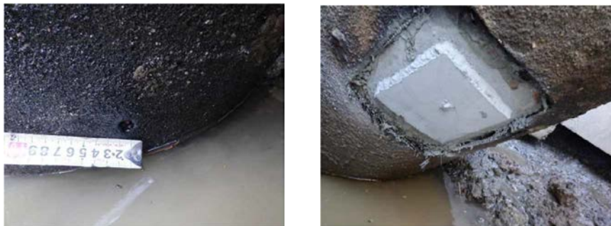
写真－9 漏水事故発生状況（左：漏水した鋼製管、右：漏水箇所の補修状況）
