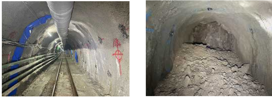
写真－7 併設水路工事实施状況（左：2号トンネル坑内、右：トンネル掘削（発破完了））
