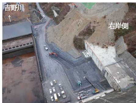
写真-1 基礎掘削状況 (増設減勢工)
