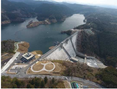
（試験湛水中（令和6年3月））
