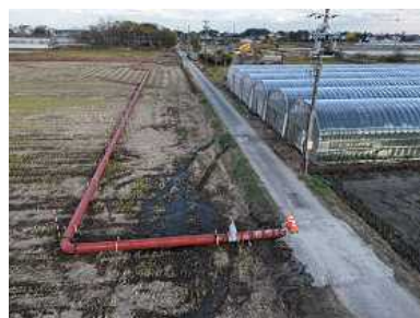
写真-12 仮廻し水路設置状況
