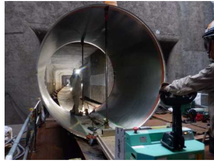
写真-10 施工状況写真（左：2号沈砂池、右：伏超水渠（内挿管挿入））
