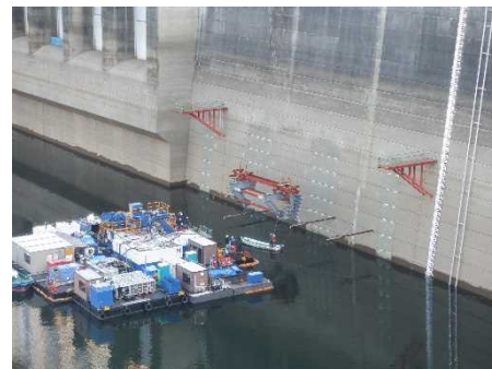
写真-2 上流仮締切設備 (鋼製台座)
