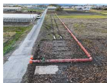
写真-12 仮廻し水路設置状況
