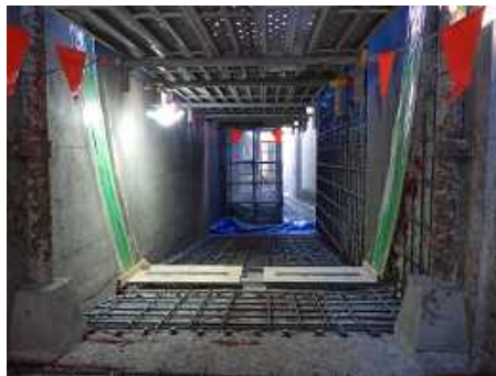
写真-6 耐震補強工事実施状況 (左: 水路補強(ポリマーセメント増厚工)、右: 開水路法面補強)
