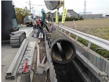
写真-5 改築工事実施状況 (左: 既設管路撤去、右: 仮廻し水路設置)
