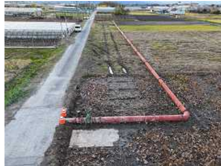
写真-5 改築工事実施状況 (左: 既設管路撤去、右: 仮廻し水路設置)
