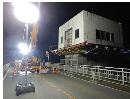
写真－1 利根大堰耐震補強工事実施状況（左：ゲート開閉器撤去工事、右：上屋撤去工事（夜間施工））
