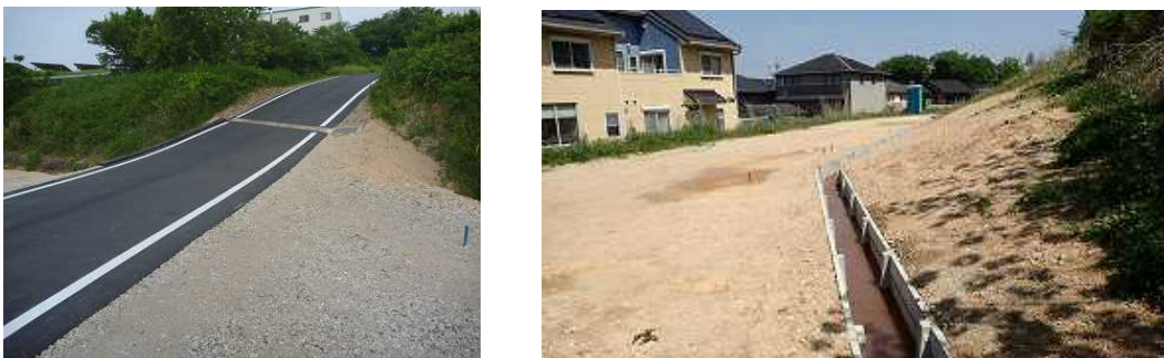
写真-4 復旧工事実施状況（左：舗装復旧、右：柵渠復旧）
