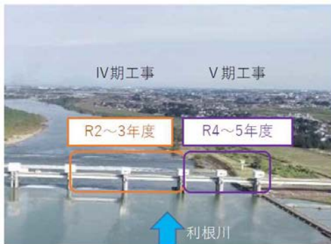
工事計画見直し前
