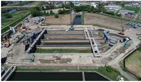
写真-10 施工状況写真（左：2号沈砂池、右：伏超水渠（内挿管挿入））
