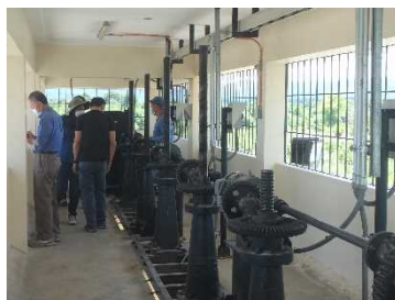
現地調査（Lasang川農業用取水堰）
