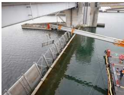
写真-11 利根大堰補修用ゲート設置状況（左：設置状況、右：運用状況）
