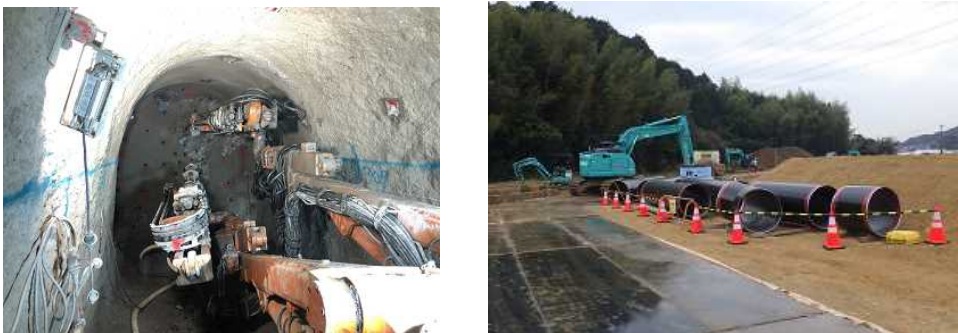
写真-3 工事実施状況（左：西部幹線併設水路（トンネル工事）、右：東部幹線併設水路（管水路工事））
