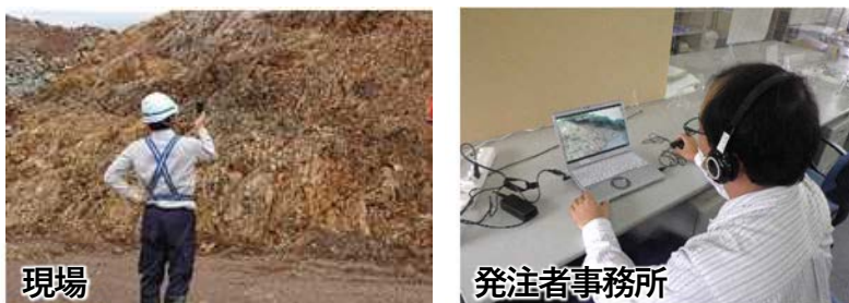
写真－7 工事マネジメント・プラットフォーム（遠隔臨場の状況）
