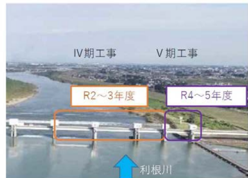
工事計画見直し後
