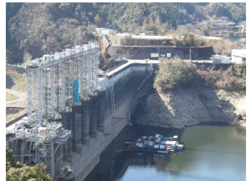
（貯水池側施工状況（令和6年1月））
