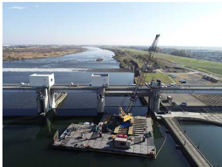
写真－1 利根大堰耐震補強工事実施状況（左：ゲート開閉器撤去工事、右：上屋撤去工事（夜間施工））
