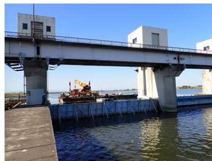
写真-11 利根大堰補修用ゲート設置状況（左：設置状況、右：運用状況）
