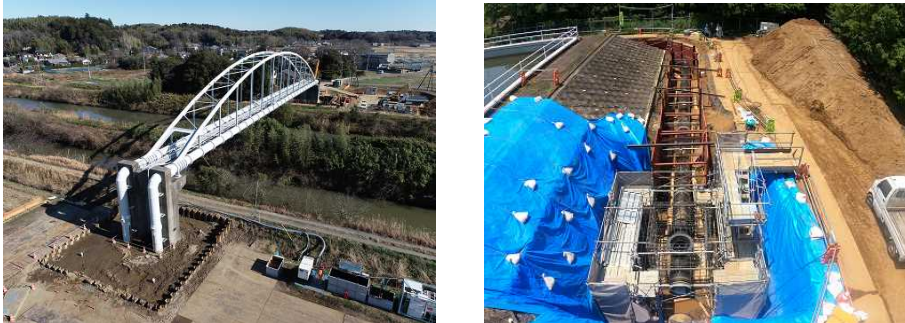
写真-2 改築工事実施状況（左：根木名水管橋耐震補強、右：加圧機場バイパス管路）
