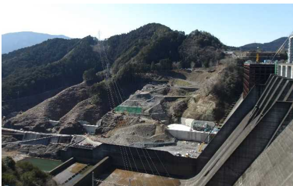
（本体工事：増設洪水吐き施工状況（令和6年1月））
