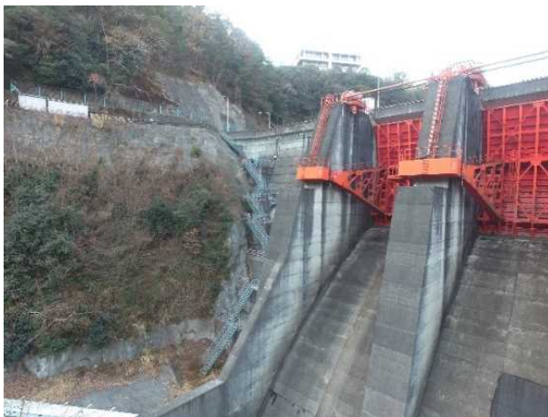
図-1 新宮ダム右岸側門柱
