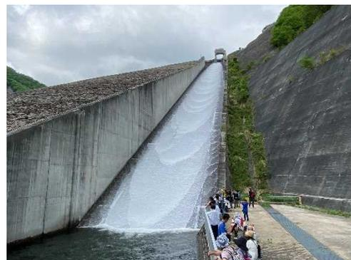
写真-2 奈良俣ダムの点検放流状況
