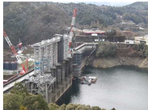
（貯水池側施工状況（令和7年1月））
