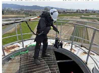
写真-8 ICT等新技术を活用した機能診断調査（福岡導水）（水中ドローン投入状況）
