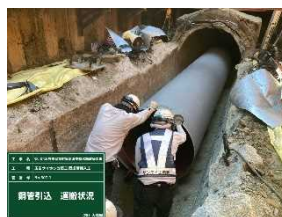
鋼管搬入状況
