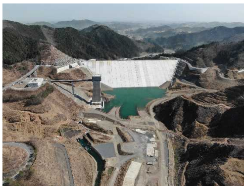
(本体工事：施工状況(令和7年3月))
