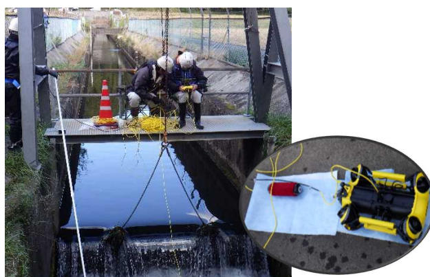
写真－1 三重用水での農研機構実証試験状況
