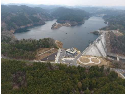
（試験湛水中（令和7年3月））
