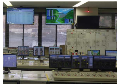
南摩ダム管理用制御処理設備（整備中） 徳山ダム管理用制御処理設備（整備中） 写真－１ 管理用制御処理設備等の整備状況
