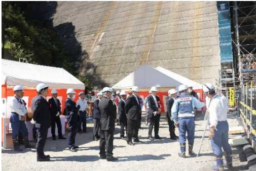
（堤体削孔開始見学状況）
