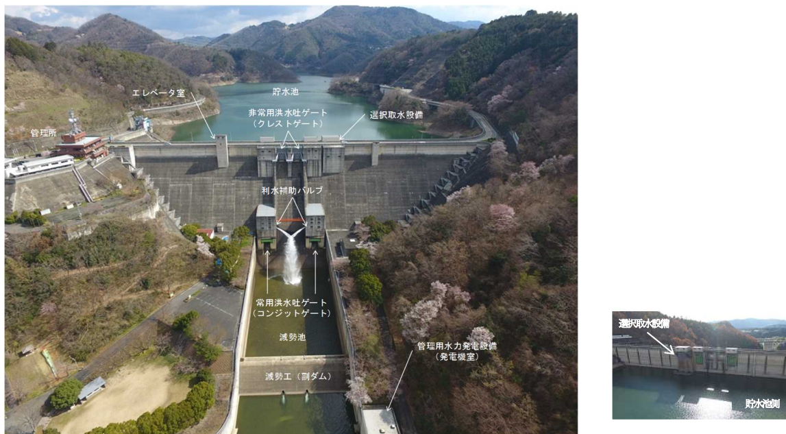
図-3 ダムの基本的な設備例（一庫ダム：重力式コンクリートダム）
