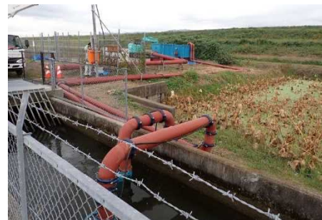
写真-13 仮廻し水路設置状況
