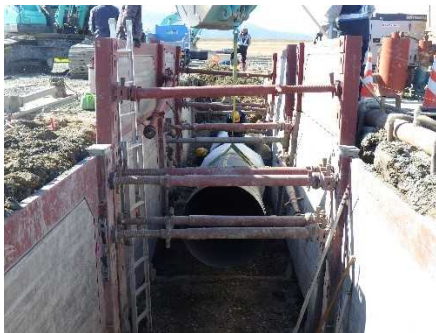
写真－4 改築工事実施状況（左：ダクトイル管布設、右：揚水機場建屋工事）
