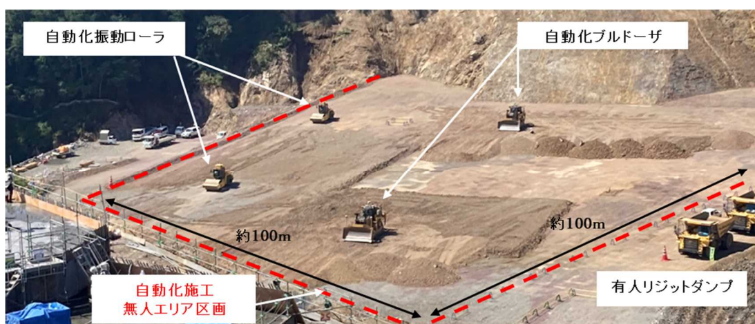
写真-9 南摩ダムの堤体盛立における自動化施工状況
