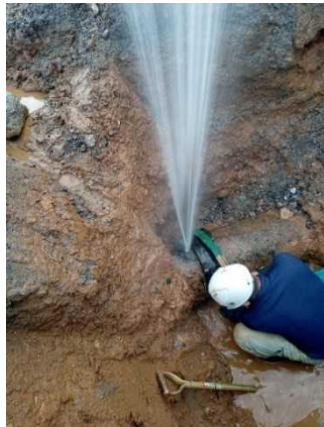
写真－9 漏水事故発生状況（左：漏水した鋼製管、右：漏水箇所の補修状況）
