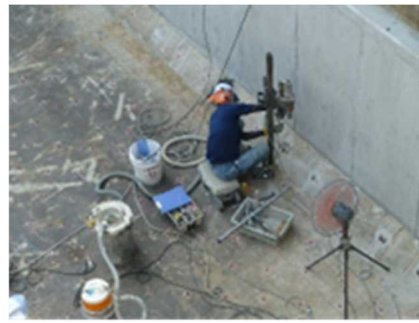
写真-12 施工状況写真（左：2号沈砂池、右：あと施工せん断補強筋工（2号沈砂池））
