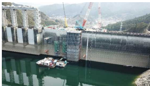
写真-1 上流仮締切設備工事
