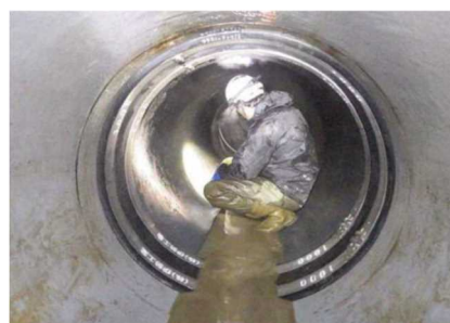
継手補強材設置状況
