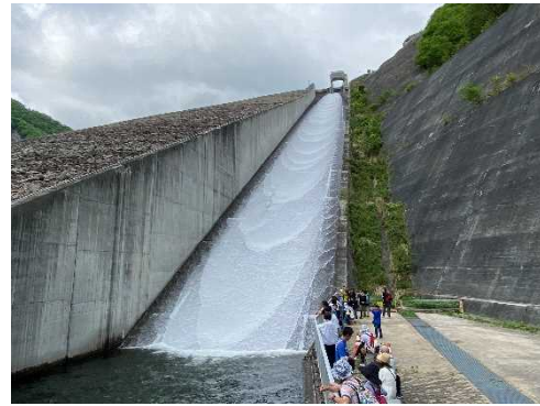
写真-4 奈良俣ダムの点検放流状況
