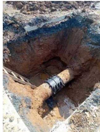
写真－9 漏水事故発生状況（左：漏水した鋼製管、右：漏水箇所の補修状況）
