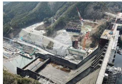
写真-2 増設洪水吐き工事
