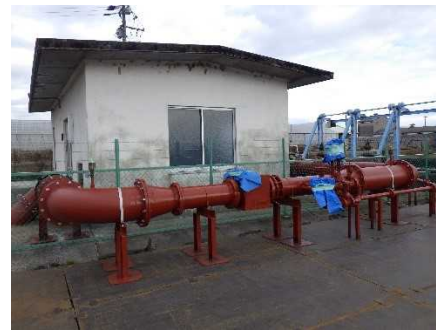
写真－4 改築工事実施状況（左：ダクトイル管布設、右：揚水機場建屋工事）
