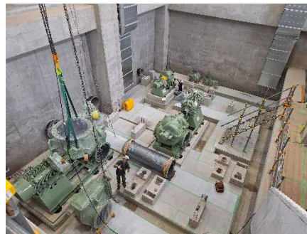
写真－5 工事実施状況（左：原形復旧工事、右：揚水ポンプ設備設置）
