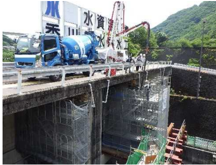
写真－6 耐震補強工事実施状況（左：取水工耐震補強、右：ブロック積み法面耐震補強）
