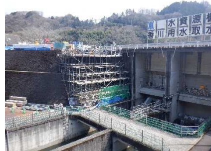
写真－6 耐震補強工事実施状況（左：取水工耐震補強、右：ブロック積み法面耐震補強）
