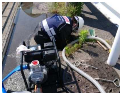
空気弁からの漏水対応
