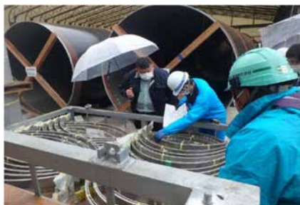
継手補強材確認
