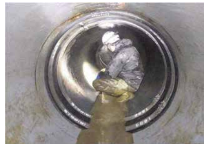
継手補強材設置状況
