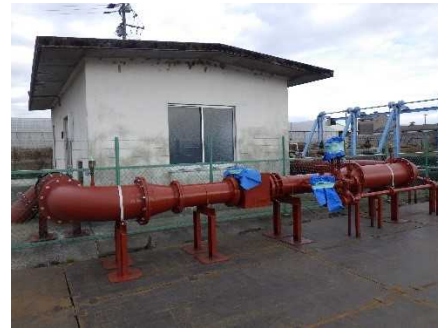
写真-4 改築工事実施状況（左：ダクトイル管布設、右：揚水機場建屋工事）
