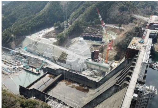
（本体工事：増設洪水吐き施工状況（令和7年3月））
