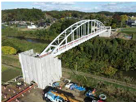
写真－1 改築工事実施状況（左：根木名水管橋耐震補強、右：新川揚水機場ポンプ設備改修）
