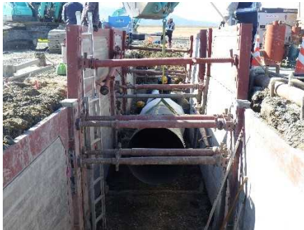
写真-4 改築工事実施状況（左：ダクトイル管布設、右：揚水機場建屋工事）
