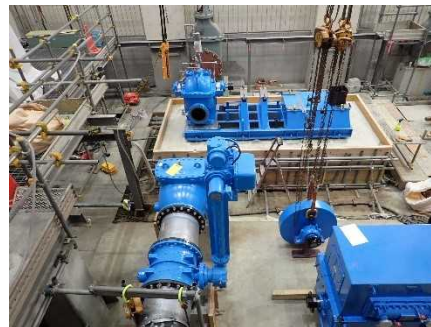
写真－1 改築工事実施状況（左：根木名水管橋耐震補強、右：新川揚水機場ポンプ設備改修）
