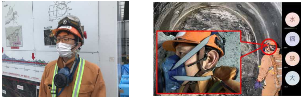
写真-10 骨伝導無線（イヤホン）装着状況（豊川用水二期）
