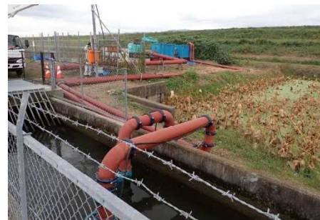
写真-13 仮廻し水路設置状況
