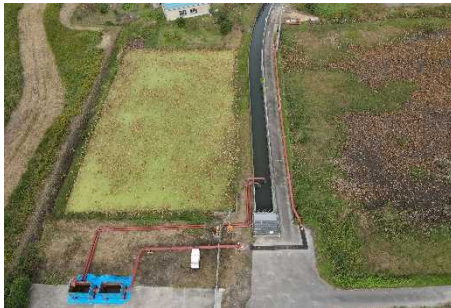
写真-13 仮廻し水路設置状況
