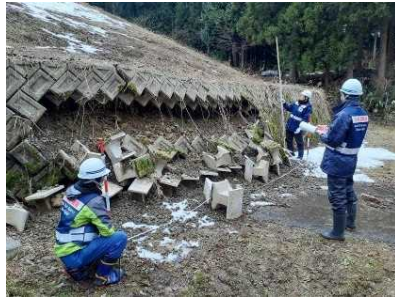
写真-1 ため池点検(左:ため池の法面点検、右:水位低下作業)
