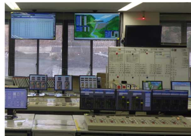
南摩ダム管理用制御処理設備（整備中） 徳山ダム管理用制御処理設備（整備中） 写真－1 管理用制御処理設備等の整備状況
