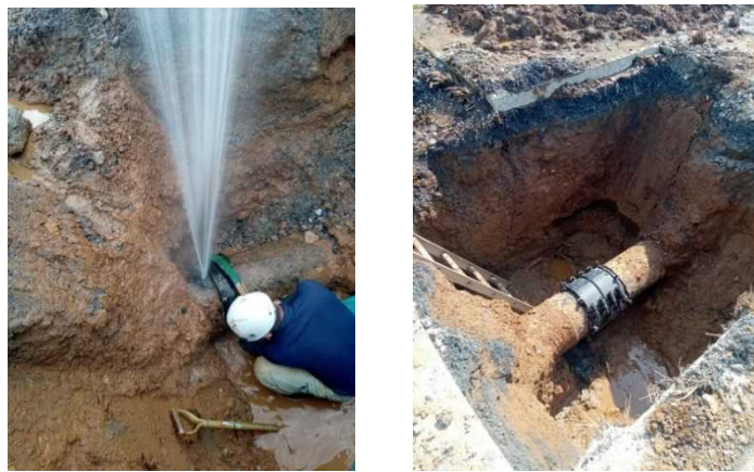
写真－9 漏水事故発生状況（左：漏水した鋼製管、右：漏水箇所の補修状況）
