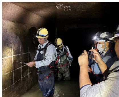
写真－2 機能診断調査の実施状況（北総東部用水）
