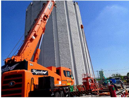
写真－6 工事実施状況（左：吐出水槽耐震補強、右：幹線水路防災対策）
