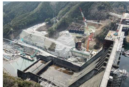
写真-2 増設洪水吐き工事
