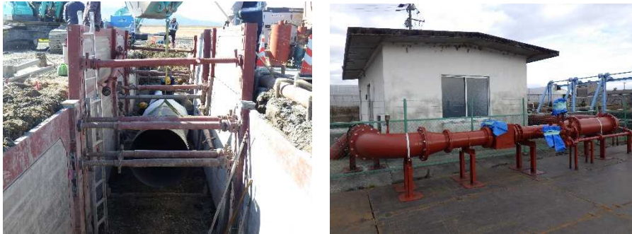
写真－3 改築工事実施状況（左：ダクトイル管布設、右：仮廻し水路設置）
