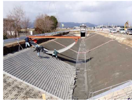
写真－6 工事実施状況（左：吐出水槽耐震補強、右：幹線水路防災対策）
