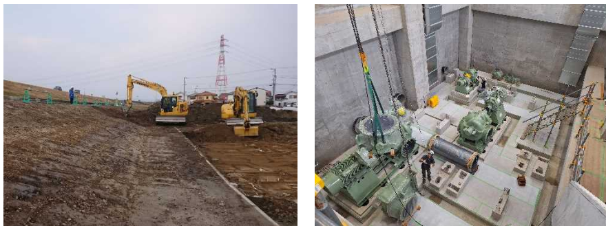
写真－4 工事実施状況（左：原形復旧工事、右：揚水ポンプ設備設置）
