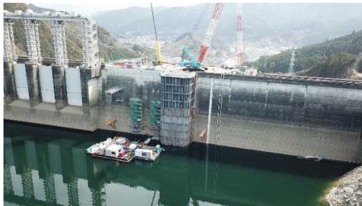
写真-1 上流仮締切設備工事
