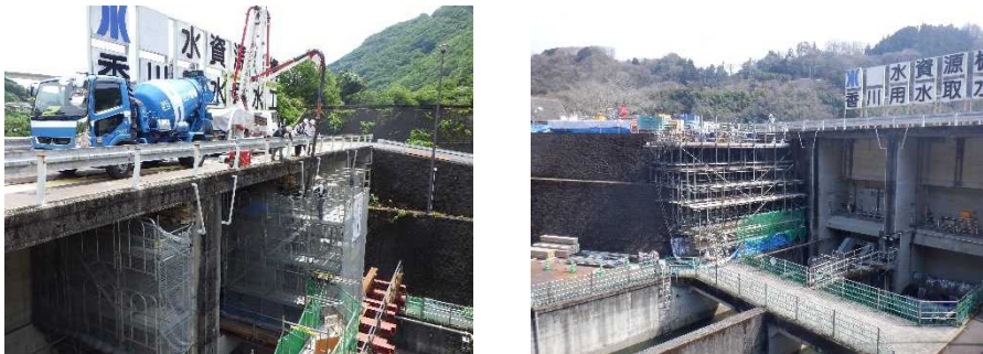
写真－5 耐震補強工事実施状況（左：取水工耐震補強、右：ブロック積み法面耐震補強）
