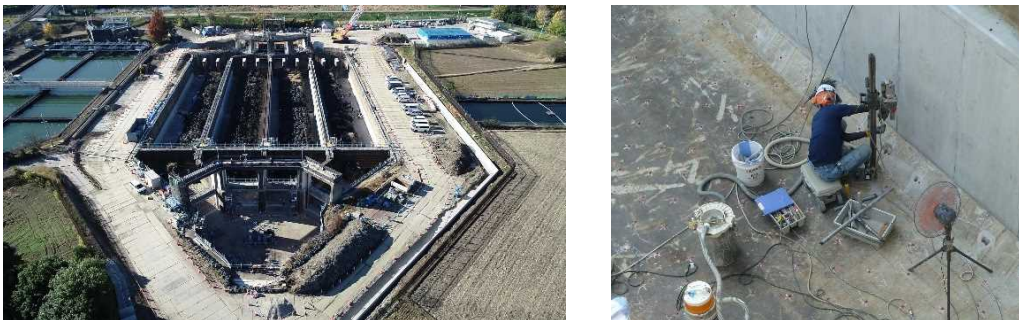
写真-11 施工状況写真（左：2号沈砂池、右：あと施工せん断補強筋工（2号沈砂池））
