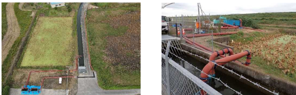
写真-12 仮廻し水路設置状況
