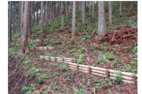
移動抑制対策(筋工)
