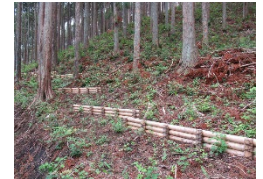
移動抑制対策(筋工)
