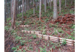
移動抑制対策(筋工)
