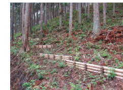
移動抑制対策(筋工)
