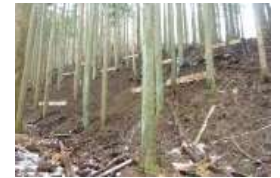
移動抑制対策(筋工)
