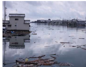
【東日本大震災被害状況】
