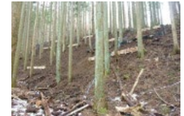
移動抑制対策(筋工)
