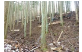
移動抑制対策(筋工)
