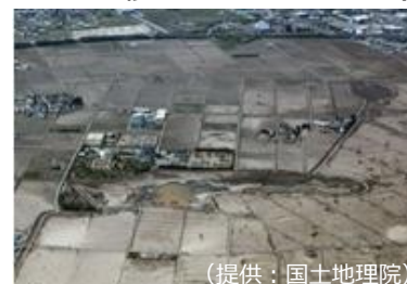
農地の復旧事例（仙台市）
