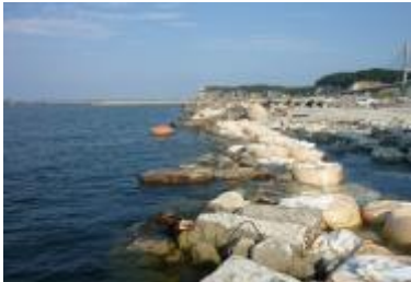
岸壁の復旧事例（松川浦漁港）
