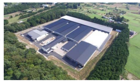
フェリスラテ施設全景
