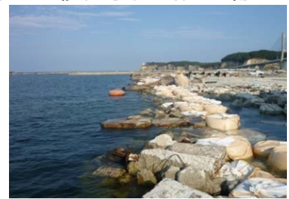
岸壁の復旧事例（松川浦漁港）
