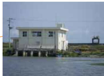
【南相馬】村上第二排水機場
