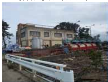
【名取川】関上排水機場
