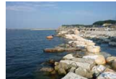
岸壁の復旧事例（松川浦漁港）
