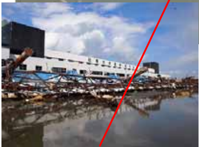
市場の倒壊、冠水
