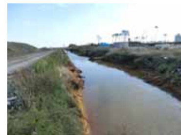
【仙台東】大堀排水路
