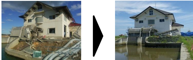
排水機場の復旧状況(谷地排水機場)
