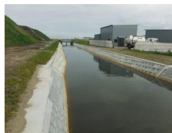
津波で損壊した排水路の復旧状況
