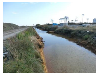
【仙台東】大堀排水路
