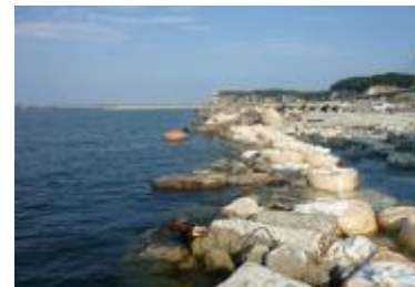
岸壁の復旧事例 (松川浦漁港)
