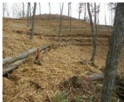
筋工による放射性物質の移動抑制対策
