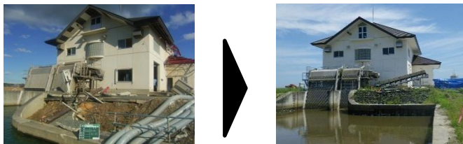
排水機場の復旧状況(谷地排水機場)
