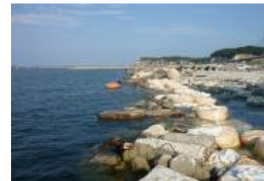
岸壁の復旧事例 (松川浦漁港)
