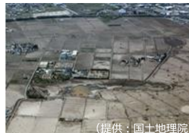
農地の復旧事例（仙台市）
