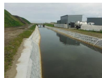
津波で損壊した排水路の復旧状況
