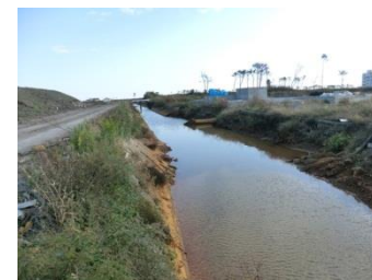
【仙台東】大堀排水路
