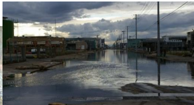
水産加工団地の冠水状況
