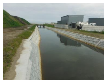
津波で損壊した排水路の復旧状況
