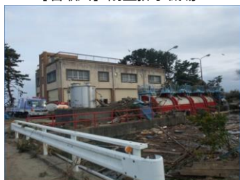
【名取川】閘上排水機場
