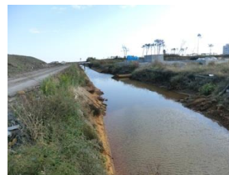
【仙台東】大堀排水路
