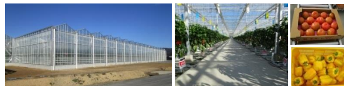
高軒高のガラス温室
