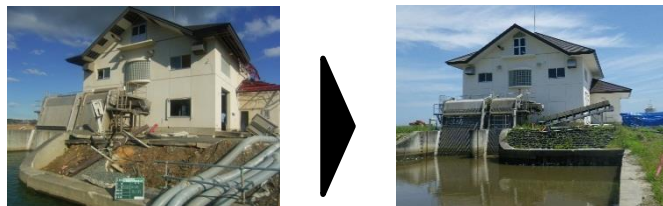
排水機場の復旧状況(谷地排水機場)
