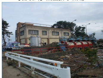
【名取川】関上排水機場
