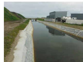
津波で損壊した排水路の復旧状況
