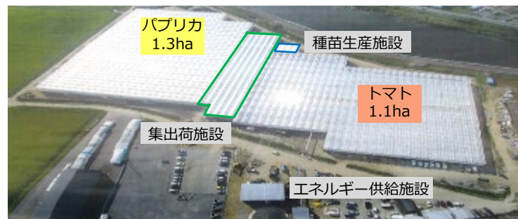
次世代施設園芸 宮城県拠点
