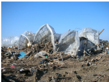
被災した園芸施設
