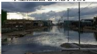
水産加工団地の冠水状況
