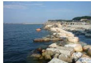
岸壁の復旧事例（松川浦漁港）
