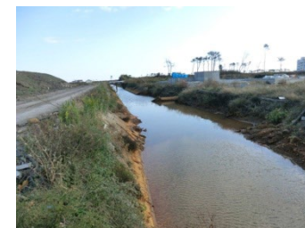
【仙台東】大堀排水路
